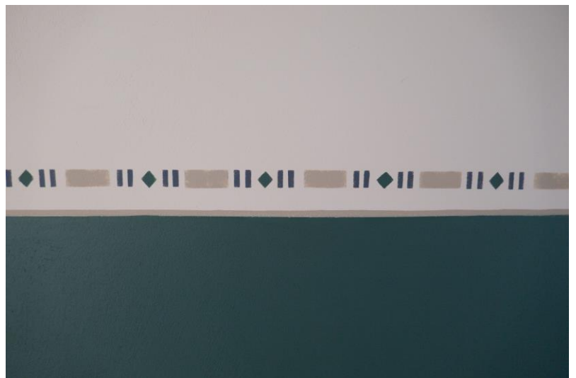
Renoviert mit viel Liebe zum Detail
